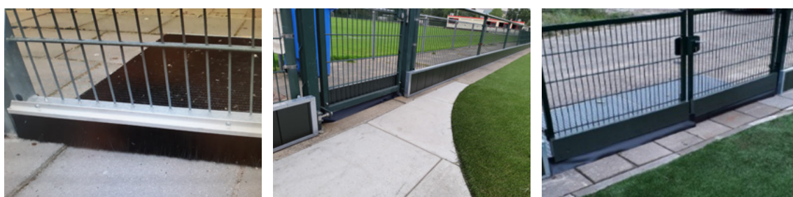
Fig. 5.5 Rubber flappen onder de poort
