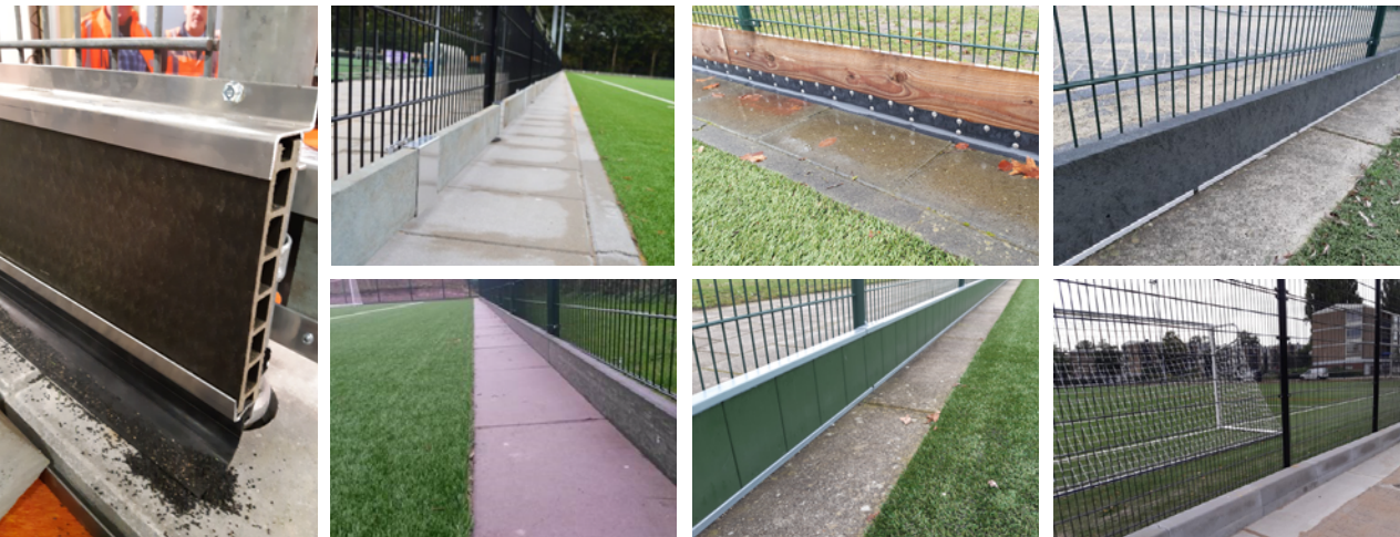
Fig. 5.2 Diverse typen kantplanken
