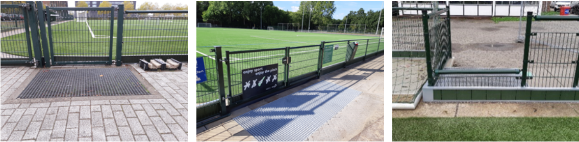
Fig. 5.4 Looprooster met optioneel een schoenenborstel
